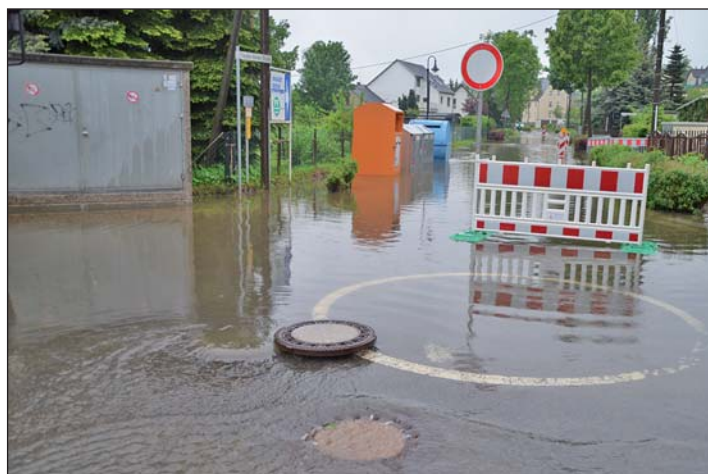
Der Goetheweg wirkt wie eine Staumauer, die Abwassergullys laufen über, die Theodor-Körner-Straße ist zu großen Teilen überflutet.
