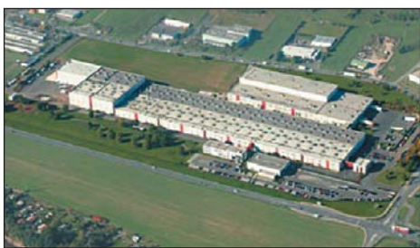
Die Keksfabrik Griesson in Kahla aus der Vogelperspektive Quelle: www.griesson-debeukelaer.de
